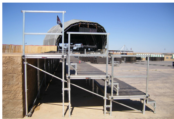
Imagen 9. Detalle riostramiento transversal de gradas
